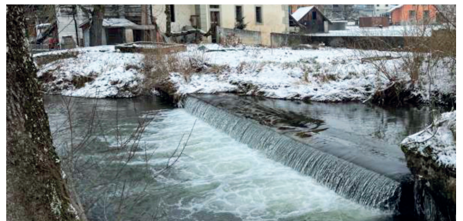
Rückbau der Schwelle (5)
