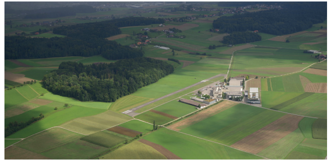
Verlegung der Altache im Bereich des Flugplatzes (3)
