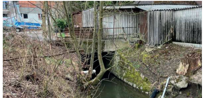
Besserer Schutz des rechtsseitigen Ufers (4)
