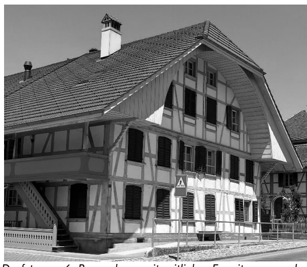
Dorfstrasse 6, Bauernhaus mit seitlicher Erweiterung und neuerer Ründi über die ganze Hausbreite
